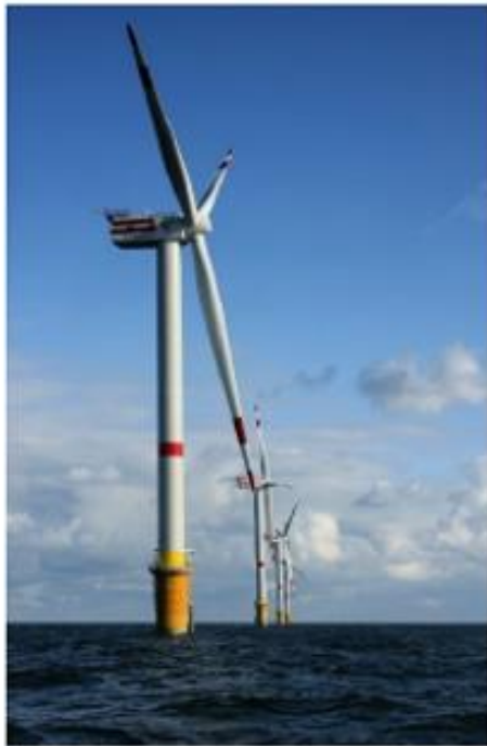
図1：新たに建設された風力タービン 北海のベルギー側、沖合28kmにあるThornton Bank タービンの水面からの高さは157m、海底からの高さは184m ©Hans Hillewaert, via Wikimedia Commons.
