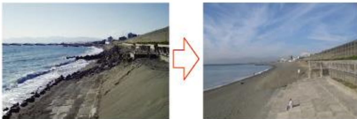
図 31 茅ヶ崎中海岸における養浜、宇多高明氏資料。左が砂の投入前、右が投入後。出典：土木学会 HP 42
