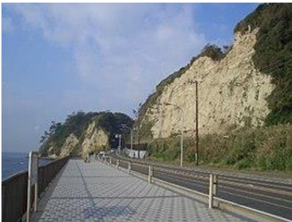
図 28 神奈川県稲村ヶ崎。このような護岸工事によって、かつて崖から供給されていた土砂が無くなった。これに伴って、近隣の砂浜で浸食が起きている。 41
