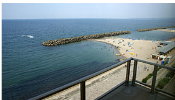
図 30 皆生海岸（鳥取県）で行われている離岸堤による養浜
