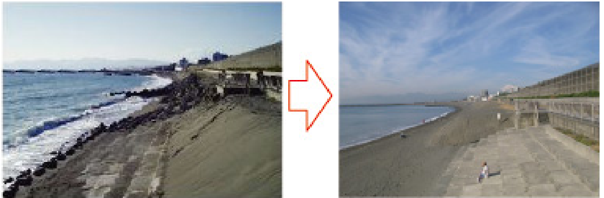
図 31 茅ヶ崎中海岸における養浜、宇多高明氏資料。左が砂の投入前、右が投入後。出典：土木学会 HP 43
