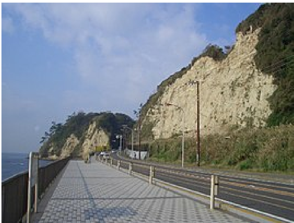
図 28 神奈川県稲村ヶ崎。このような護岸工事によって、かつて崖から供給されていた土砂が無くなった。これに伴って、近隣の砂浜で浸食が起きている。 42
