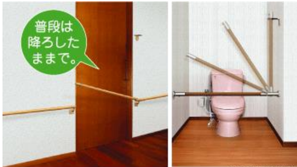
施工実例写真
