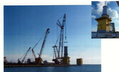
浮体と7MW風車タワーの組立て状況
