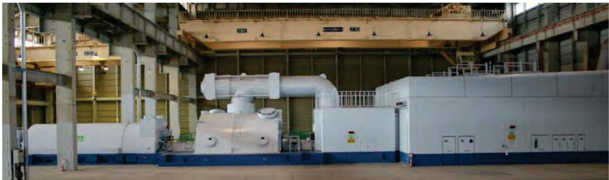
東京電力川崎1-1系列：出力50万KW：発電効率 53% (高位発熱量基準、送電端)
