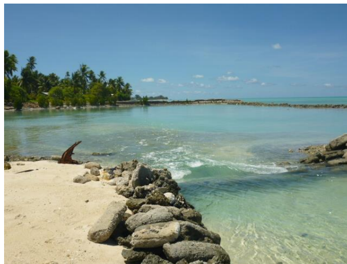
(c) 堤防のみを建設したが、まだ埋め立てられていない造成地。 満潮になって海水が流れ込んできている。
