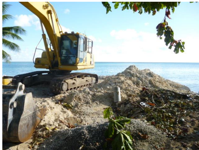
(a) 土地を造成しているところ。ベシオ付近。
