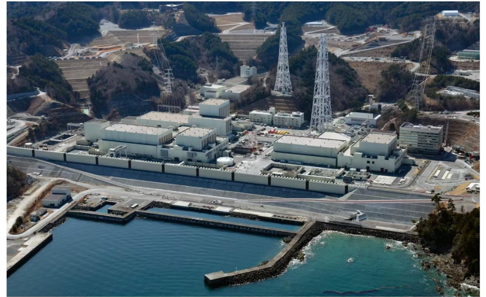
東北電力女川原子力発電所
