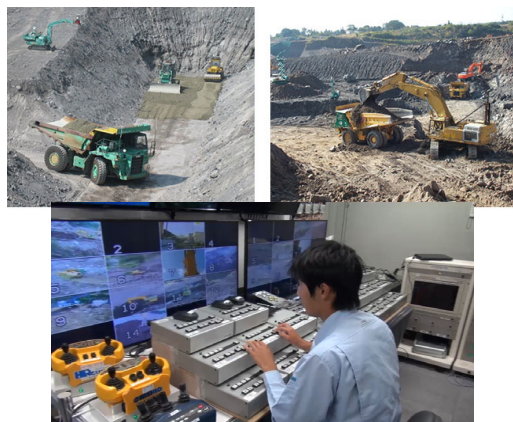
無人化施工（建設無人化施工協会）
