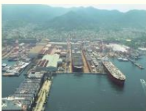
呉湾上空から見るジャパンマリユニテッド(株)呉事業所
