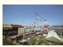
歴史の見える丘から見るジャパンマリユニテッド(株)呉事業所
