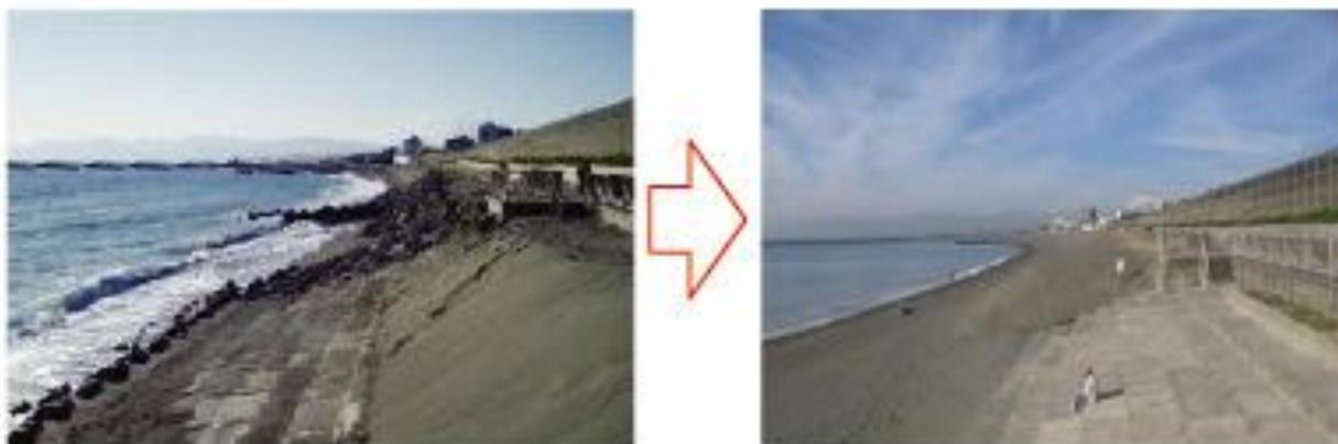
図 31 茅ヶ崎中海岸における養浜、宇多高明氏資料。左が砂の投入前、右が投入後。出典：土木学会 HP <sup>43</sup>
