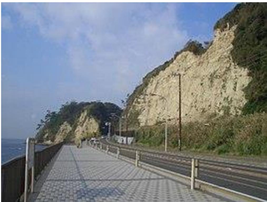
図 28 神奈川県稲村ヶ崎。このような護岸工事によって、かつて崖から供給されていた土砂が無くなった。これに伴って、近隣の砂浜で浸食が起きている。<sup>42</sup>
