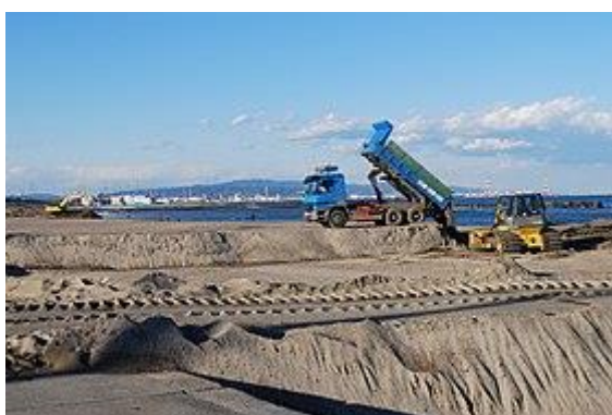
図 29 阿字ヶ浦海岸（茨城県ひたちなか市）で行われている砂の投入
