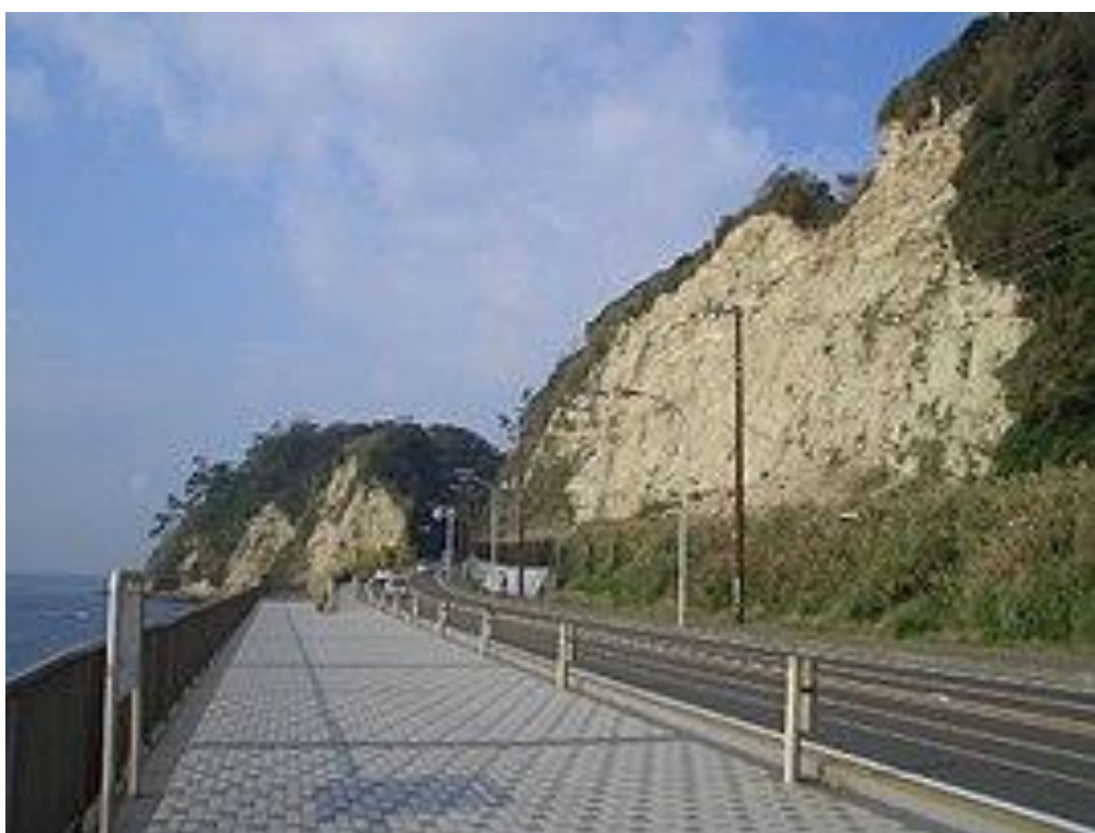
図 28 神奈川県稲村ヶ崎。このような護岸工事によって、かつて崖から供給されていた土砂が無くなった。これに伴って、近隣の砂浜で浸食が起きている。 42
