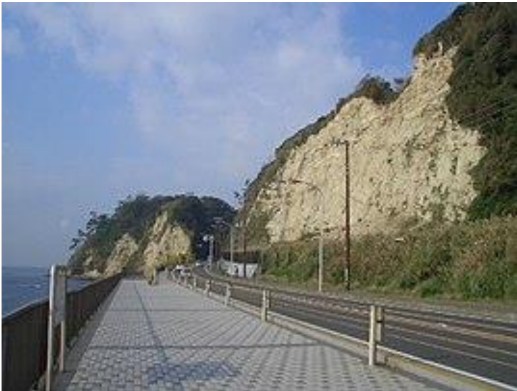
図 28 神奈川県稲村ヶ崎。このような護岸工事によって、かつて崖から供給されていた土砂が無くなった。これに伴って、近隣の砂浜で浸食が起きている。 41
