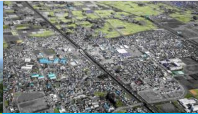
都市基盤が整備された矢幅駅周辺
