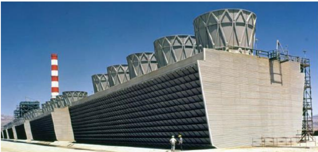
図2 DAC で用いる CO 2 の湿式回収装置 (Keith 氏講演資料より)
