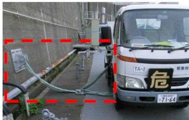
飛散対象物をアンカー、ウエイト等にて飛散しないよう固縛。
