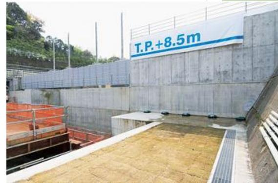
大津波警報が発令した場合に、中央制御室からの遠隔操作により、地震・津波発生後13分以内に、全ての防潮ゲート(4門)を確実に閉止する。遠隔操作不能時を考慮し現地での手動操作も可。想定される津波の最大の高さ(入力津波)をT. P+4. 8mとしている。
