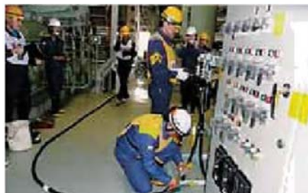
電源車の接続訓練
