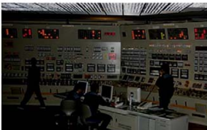
すべての電源を失った事態を想定したシミュレーターによる対応訓練
