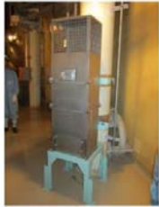
静的触媒式水素再結合装置
