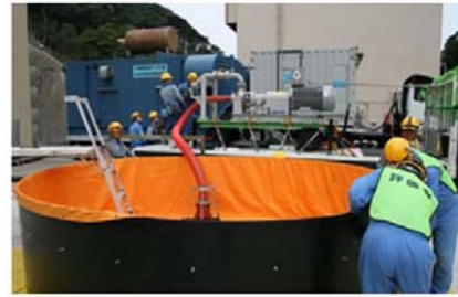
可搬式代替低圧注水ポンプを用いた、原子炉への注水訓練
