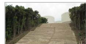
(モルタル吹付け状態)
