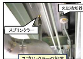
スプリンクラーの設置
