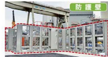
海水ポンプエリアの防護壁
