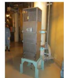
静的触媒式水素再結合装置
