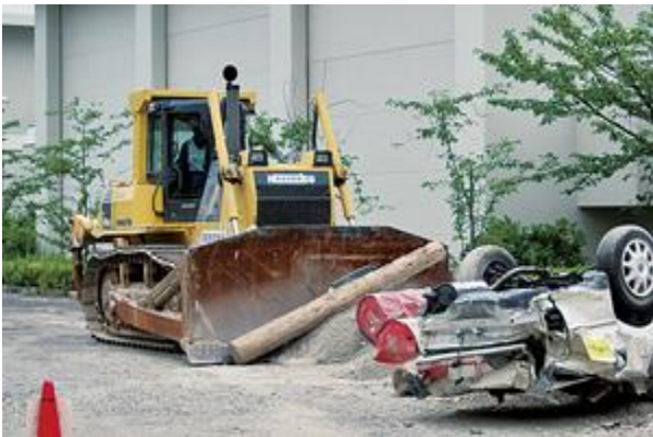
瓦礫を撤去するドーザーショベルを使った訓練
