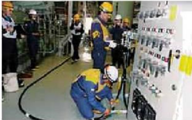
電源車の接続訓練
