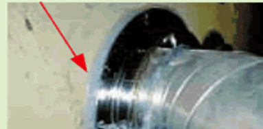
配管貫通部シール
