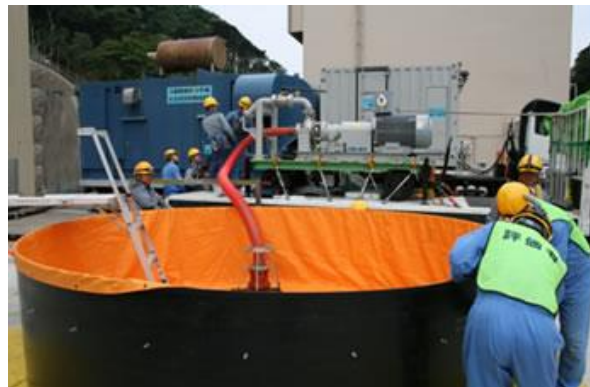
可搬式代替低圧注水ポンプを用いた、原子炉への注水訓練
