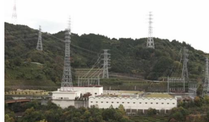
東清水周波数変換所(変換能力30万kW)
