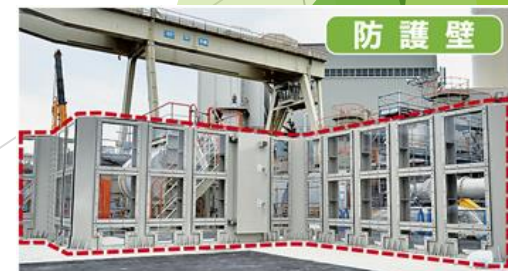
海水ポンプエリアの防護壁
