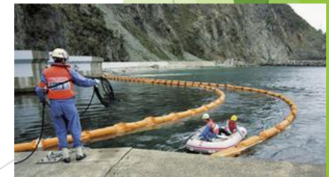
シルトフェンスの設置
