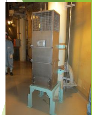
静的触媒式水素再結合装置
