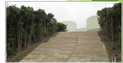
(モルタル吹付け状態)
