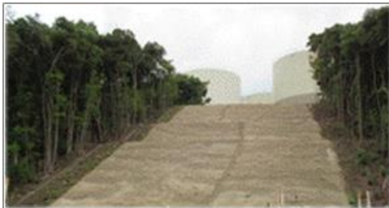
(モルタル吹付け状態)
