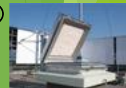
BWR原子炉建屋トップベント設備
