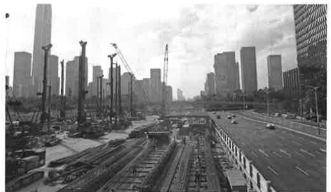
深圳の建設現場。2018年11月に筆者撮影
